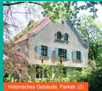
Historisches Gebäude, Parkstr. (3)
