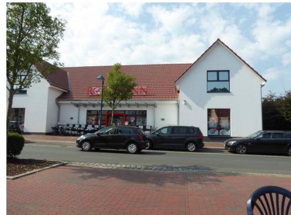
Abbildung 32: nicht ausgebautes Obergeschoss (Scheinfassade) in einem Neubau
