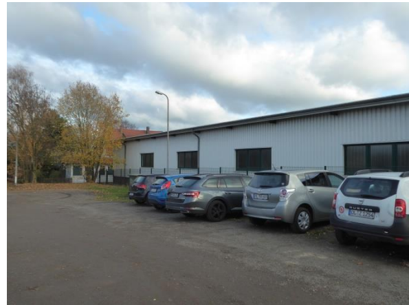
Abbildung 34: Lagerhalle am Torfplatz
