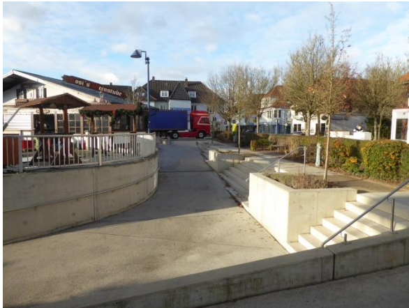
Abbildung 39: Rampe an der Nordseite des Bahnhofs - hohe Versiegelung
